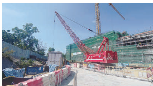
使用電池儲能系統的大型地盤設備
